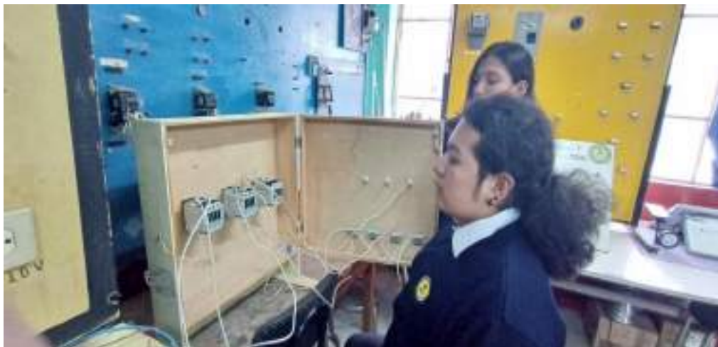
Figura 7: Prueba de funcionamiento de módulo 3
