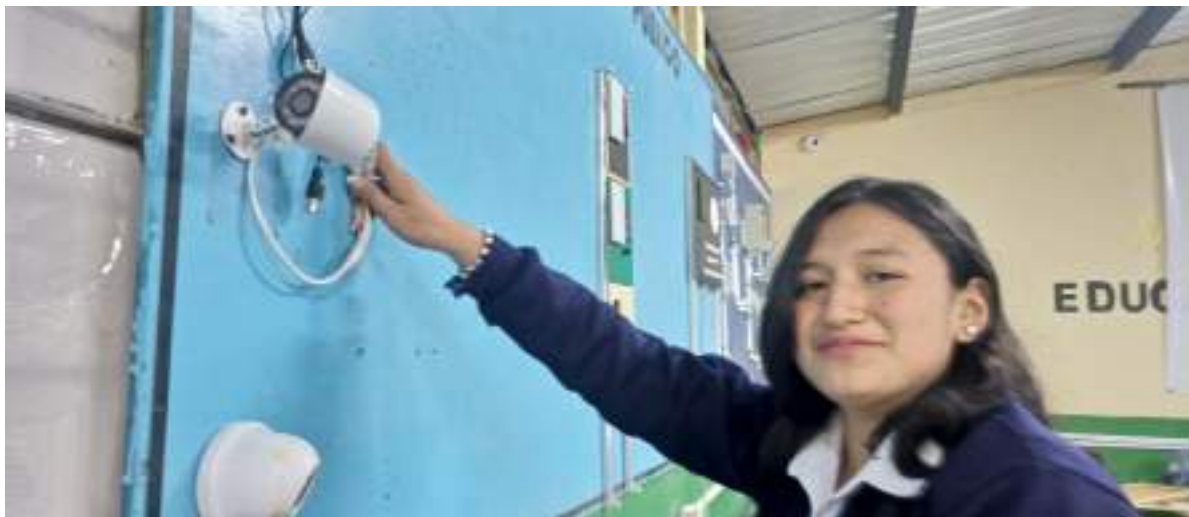
Figura 8: Prueba de funcionamiento de módulo 4
